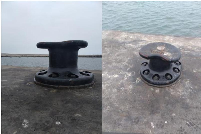
Fig.32: Bitas de 100, 120 y 150 toneladas instaladas en los muelles de STI
